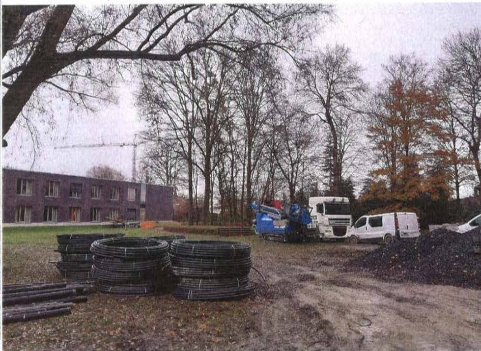
Abb. 4 Baustelleneinrichtung mit Lagerung des Sondenmaterials sowie Bohrerät im Hintergrund
